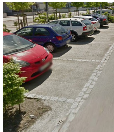
Parkering på semi-genomsläpplig yta av stenmjöl.
