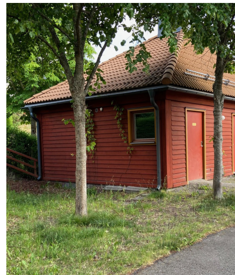
Fint gestaltat miljöhus med sadeltak och fönster.
