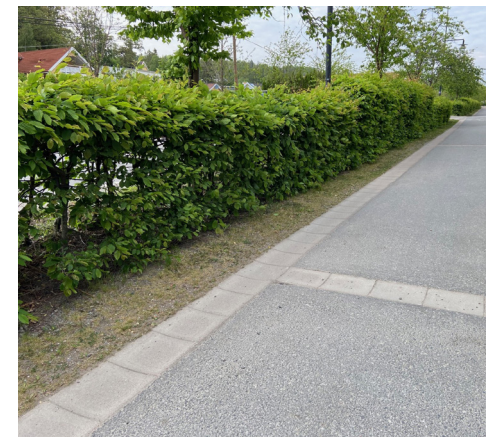
Dagvattenrännor längs gång- och cykelbana.
