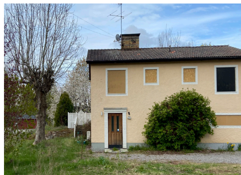
Villa på fastigheten Härnevi 25:1, nyligen riven.
