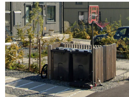
Exempel på fyrfacksskär inramade med spalje.
