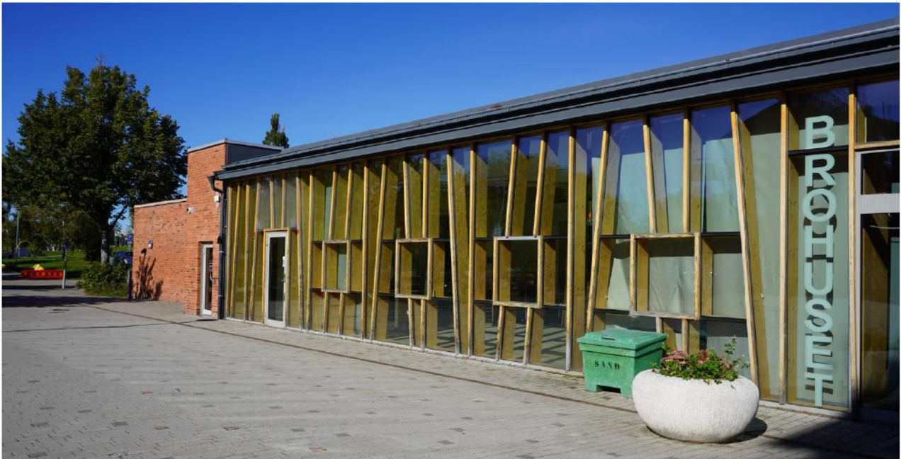
Brohusets fasad. Källa: Nyréns arkitektkontor.
