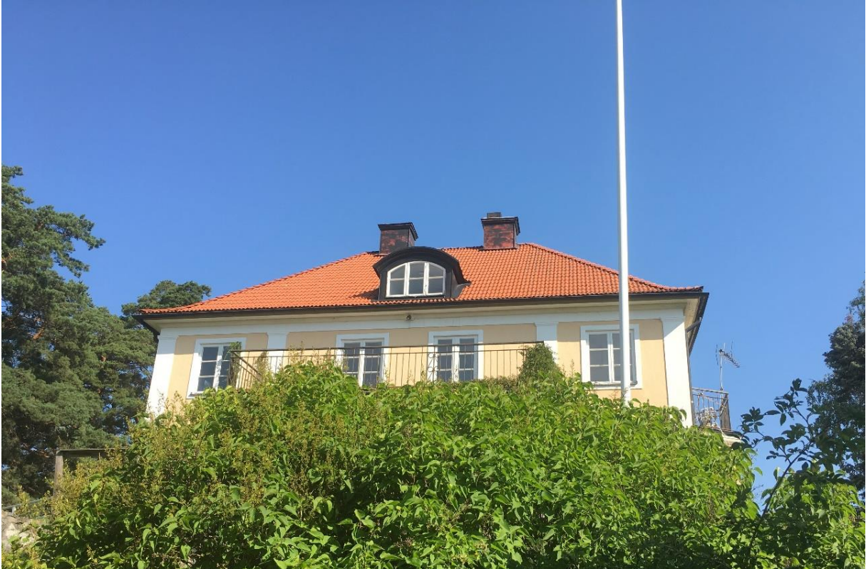
Villa skogas valmade tak med svag utsvängning vid takfoten. Symmetriska skorstenar och en takkupa i varje väderstreck.
