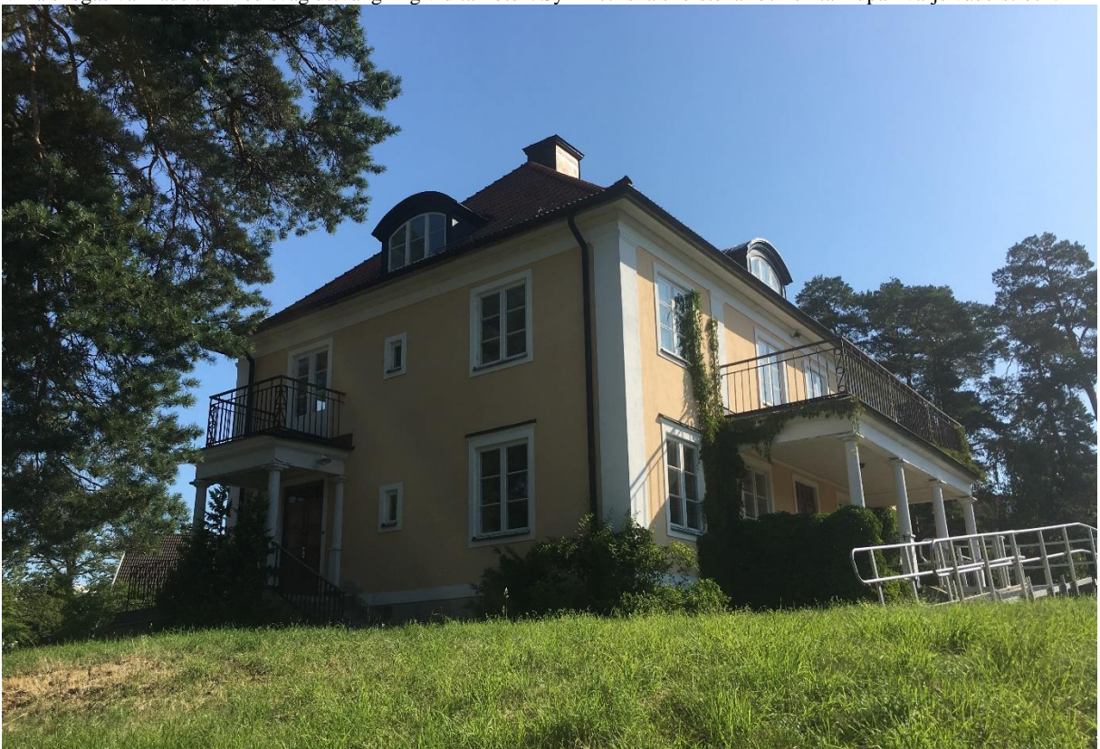
Verandor och balkonger. De kontrasterande detaljerna i fasaden syns tydligt mot den gula putsen.
