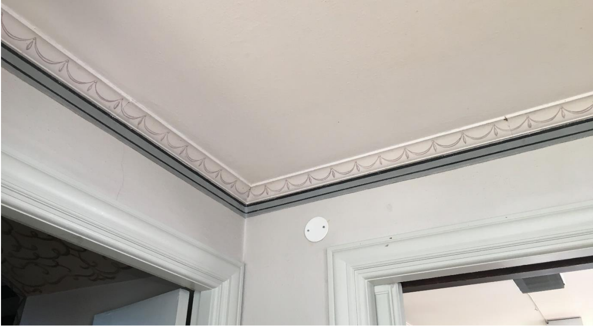
Detaljbilder av kalkmålningar på fris vid passagen mellan salong och matsal på nedervåning.
