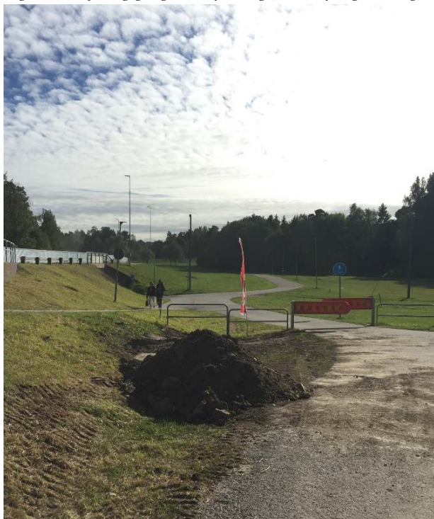
Figur 10. Befintlig gång- och cykelväg (nord-/sydlig riktning)
