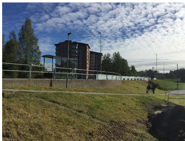
Figur 5. Granhammarsvägen. Foto: Sweco
