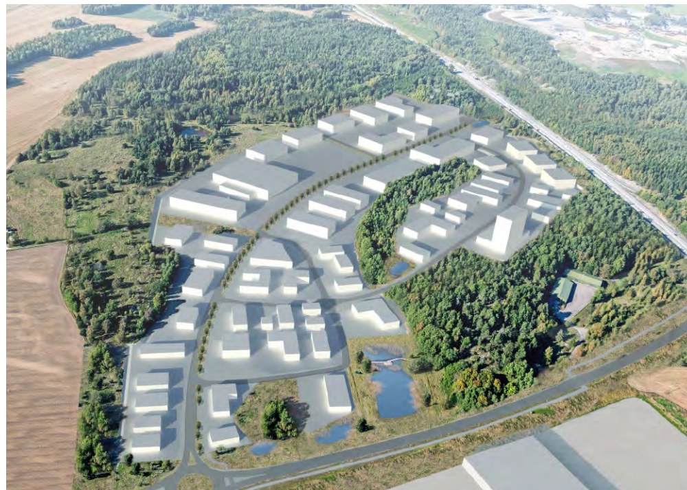
Fotomontage över företagsparken med planerade byggnadsvolymer. Vy från söder med E18 till höger i bilden.
