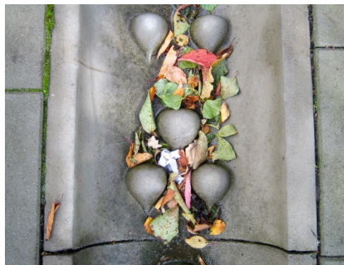
Mellanrummet mellan Finnstaskolan och förskolan Blomman. Så kallad lökränna, ett vackert och pedagogiskt sätt att fördröja dagvatten. Exempel från Augustenborg, Malmö. Foto Tema, Emelie Kjellberg
