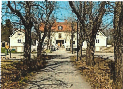
Befintliga byggnader, maj 2013.
