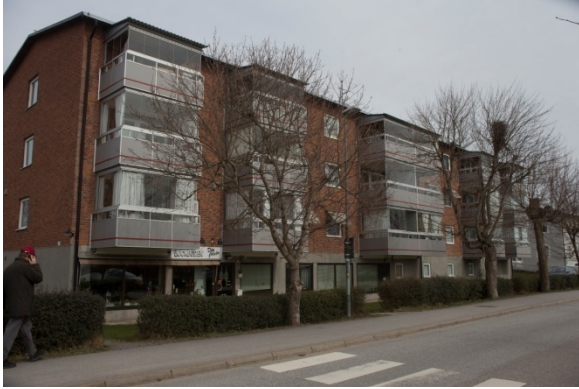
2 - Flerbostadshus i 4 våningar inkl. souterrängvån.
