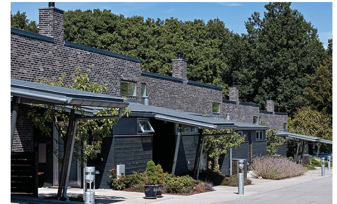
Exempel på väl gestaltad förgårdsmark framför radhus.
