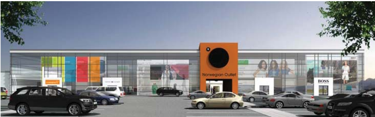
Exempel på en entré som tydligt annonserar sig genom att sticka upp över byggnaden i övrigt. Entrévolymen används samtidigt som skylyta och inrymmer vindfång.
