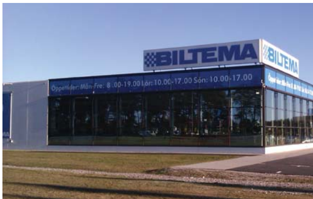
Exempel på en sluten fasad med uppglasat hörn.
