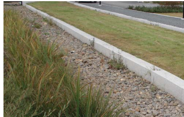
Exempel på dagvattendike som kombinerar växtlighet med stenkross.
