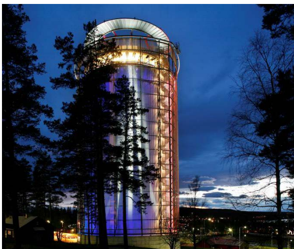
Ackumulatortank för Jämtkraft Östersund, Arctura. Arkitekt/foto: Sweco
