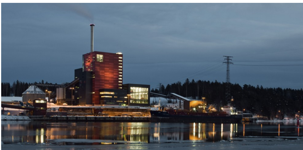
Söderenergi, Igelstaverket, Södertälje. Arkitekt: Scheiwiller Svensson Arkitektkontor AB. Foto: Åke E:son Lindman
