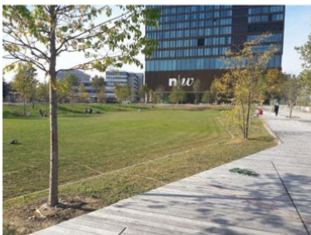
Exempel på nedsänkt grönyta som vid torrväder kan användas för bollek eller spontana aktiviteter men som vid nederbördstillfällena fungerar som utjämning och bidrar med rening. Foto: WRS.
