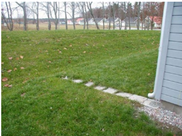
Exempel på hantering av takdagvatten genom infiltration i grönyta samt ytlig avledning mot svackdike/infiltrationsstråk. Fotot: WRS
