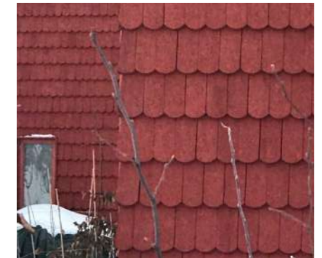
Parhus Ulvsunda/ Sandell Sandberg Exempel på god detaljbearbetning i fasadgenomförandet
