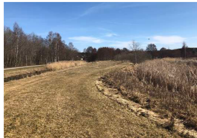
Gångstråk av klippt gräs. Sådd gräsyta på bärlager.
