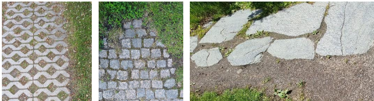
Figur 22. Exempel på genomsläpplig markbeläggning i natursten eller betong. Foton: Linnea Rosenberg
