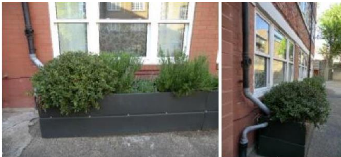
Figur 20. Exempel på upphöjd regnväxtbädd intill byggnad där vatten tillrinner via befintliga stuprör. Foto av Sweco, hämtad från dagvattenutredning PM Dagvatten Pärkans förskola av Bjerking.
