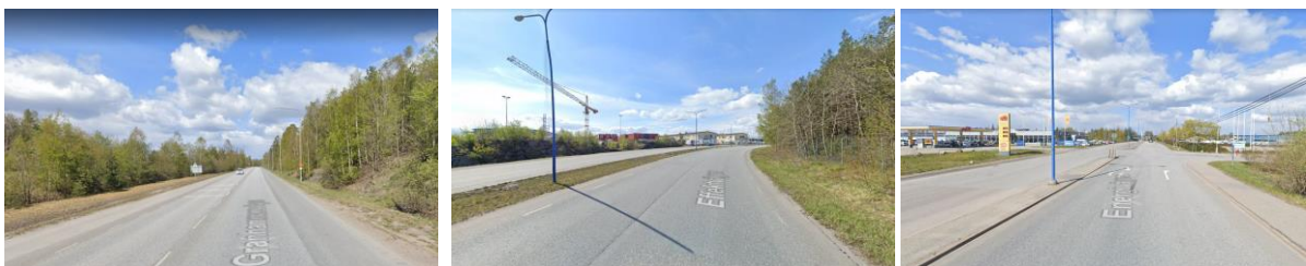
Befintlig utformning av Granhammarsvägen (till vänster) Effektvägen (mitten) och Energivägen (till höger)
