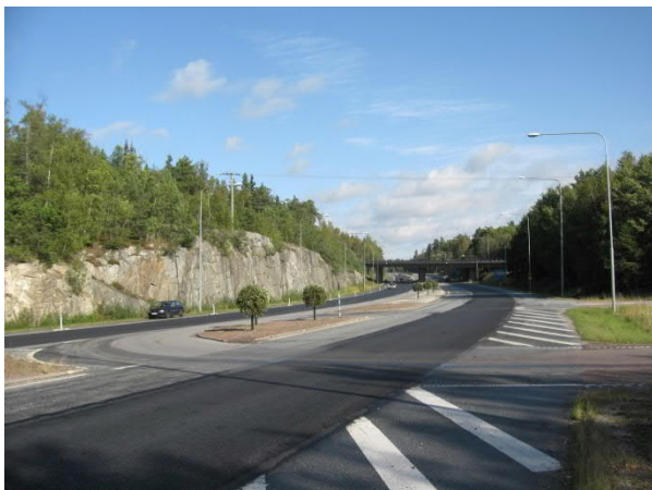
Planområdet sett från Granhammarsvägen (Tyréns 2018).
